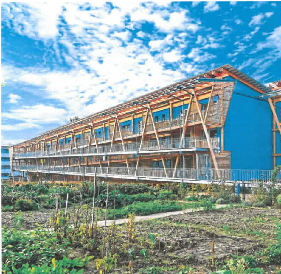
Blaue Wände, Holz-Laubengänge und eine bundesweit berühmte Rampe: das „Spiralhaus“ der Stäwog in Bremerhaven
