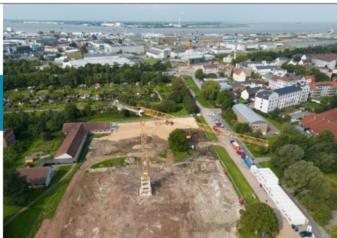
Baubeginn für das Schulzentrum Hamburger Straße
