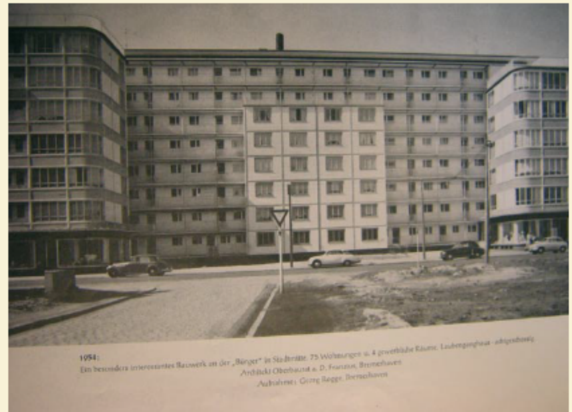
1954 – „Sing-Sing“ mit Laubenganghaus, Bürgermeister-Smidt-Straße (175 Wohnungen / 4 Läden) Aufnahme: Georg Rogge
