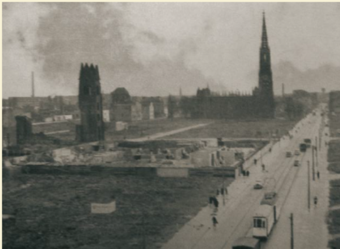
1951 – Die erste Großbaustelle an der Bürgermeister-Smidt-Straße (125 Wohnungen / 12 Läden) Aufnahme: Georg Rogge
