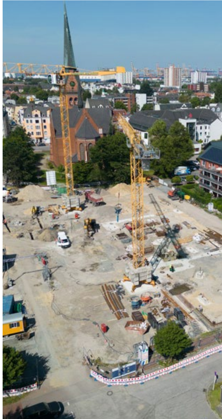
Im Herzen des Stadtteils Lehe entsteht eine neue Grundschule.
