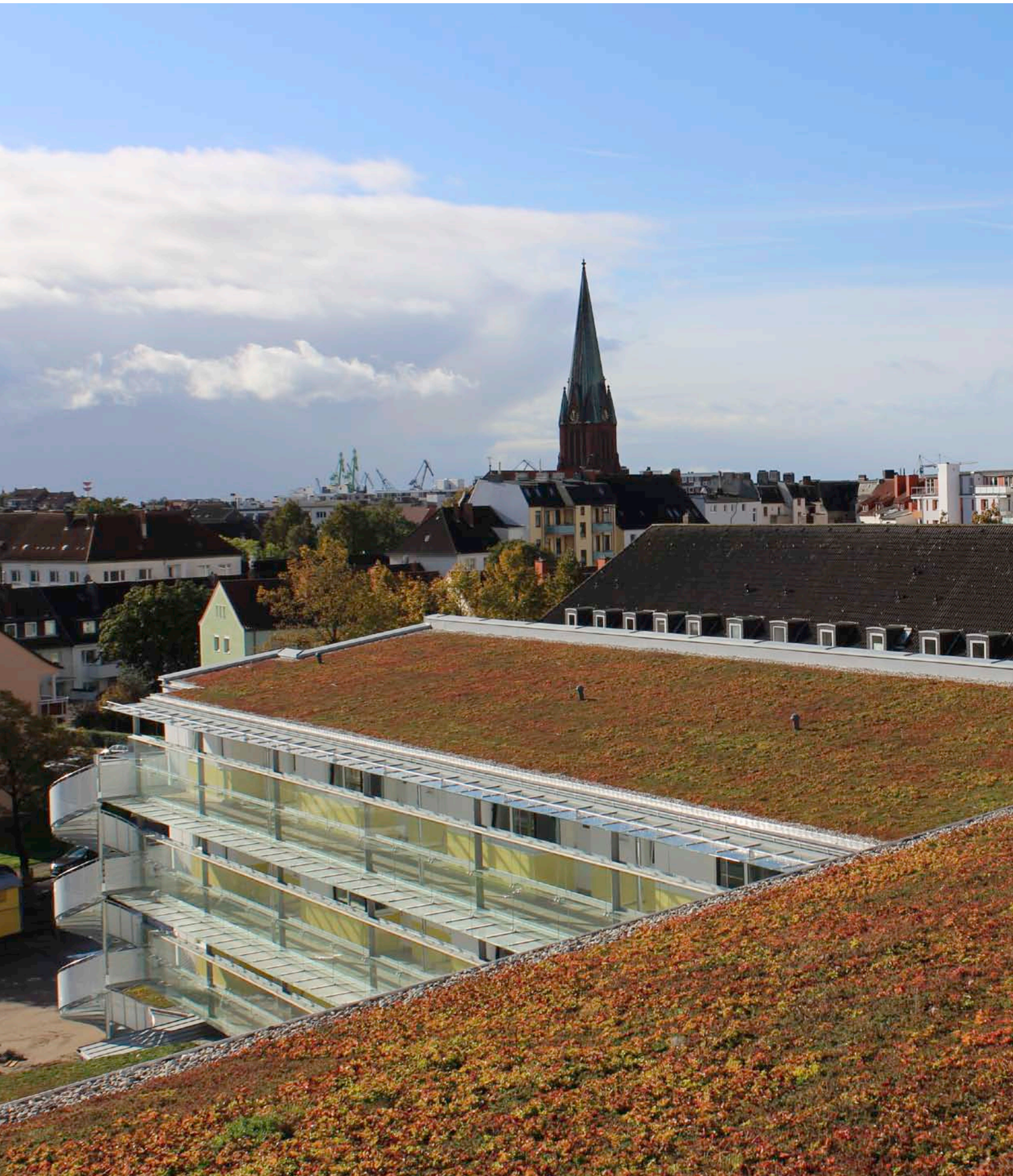
Das größte Gründach in Bremerhaven ist zurzeit in der Nürnberger Straße 3 zu finden.
