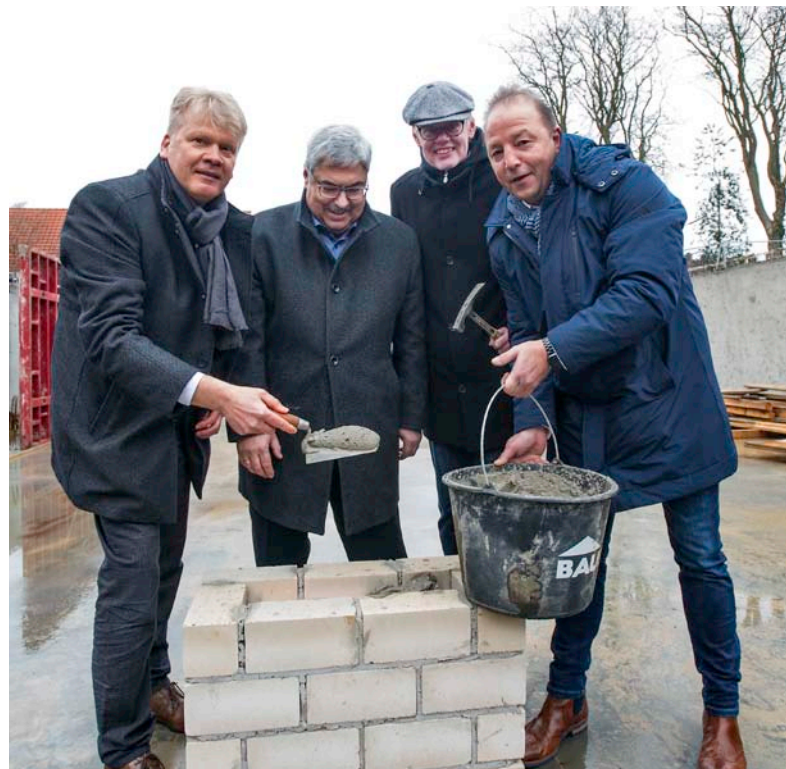
Ein großer Tag für die Surheider – die Grundsteinlegung für das lang ersehnte Mehrfamilienhaus in der Isarstraße 60
