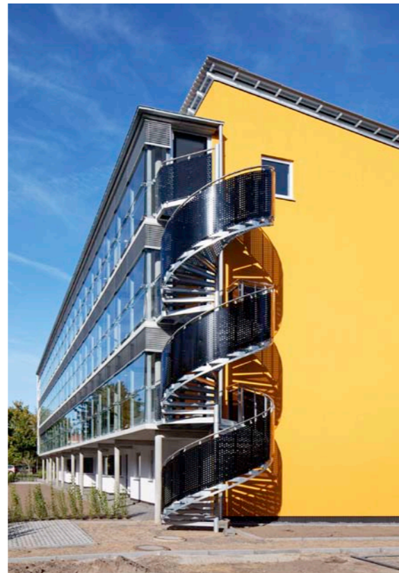
... bis hin zur Fluchttreppe außen am Gebäude.
