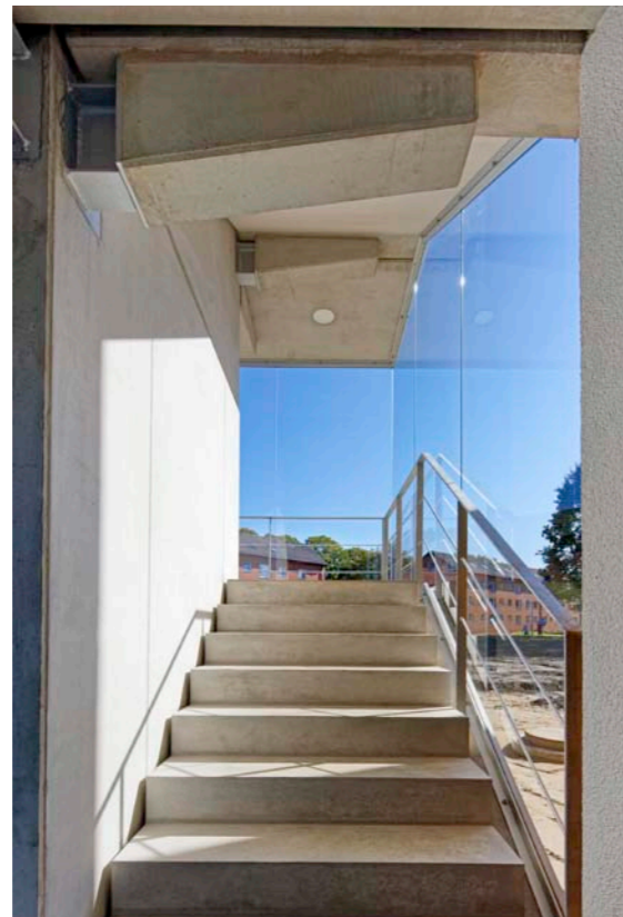
... über den Treppenaufgang rund um den Fahrstuhl ...
