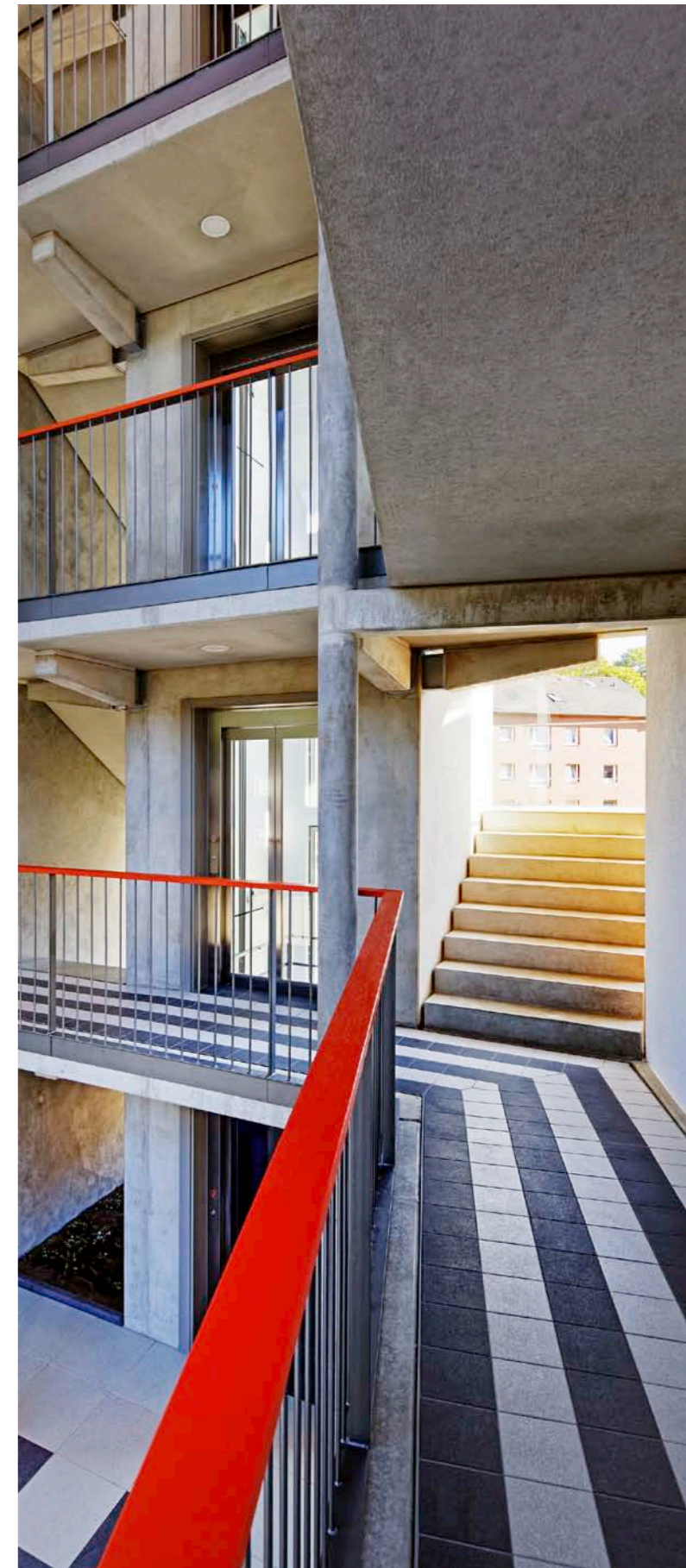
Klare Ästhetik im Atrium des STÄWOG-Neubauprojektes Engenmoor.
