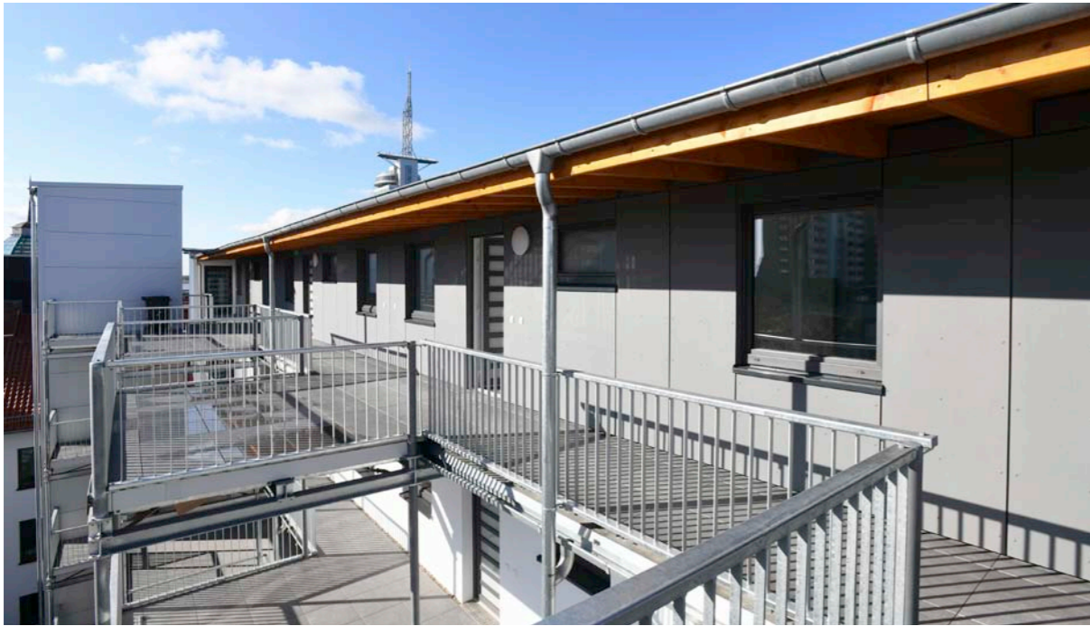
Großzügige Erweiterungen für Sonnenanbeter im neu aufgestockten Dachgeschoss.
