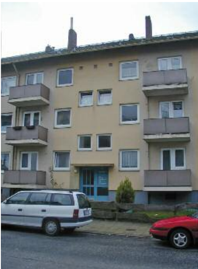
Vorher: Die Bausubstanz ist architektonisch und energetisch überaltert. Das Gebäude ist als Mietobjekt wenig attraktiv.
