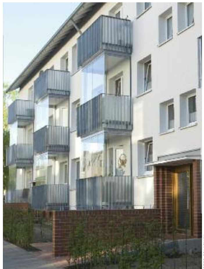
Nachher: Attraktive Fassade und Balkone mit flexibler Nutzung. Allein durch die Balkonverglasung reduzieren sich die Energiekosten, je nach Nutzerverhalten, um zirka 15 Prozent. Der CO 2 -Ausstoß wird durch die Balkonverglasung jährlich um 17,6 Tonnen gesenkt.
