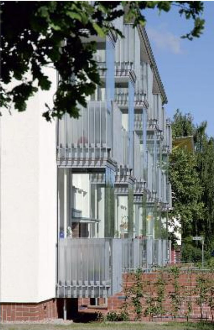
Mehr Lebensqualität bei weniger Energieverbrauch bringen die zu Ganzglaswintergärten auferüsteten Küchenbalkone.
