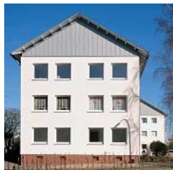
Auf Basis einer neuartigen Bindemittelkombination von Kieselol und Wasserglas: Die gedämmte Fassade wurde mit weiß getönter silikatischer Fassadenfarbe gestrichen.
