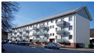
Mehr Lebensqualität bei weniger Energieverbrauch bringen die zu Ganzglaswintergärten aufgerüsteten Küchenbalkone.
