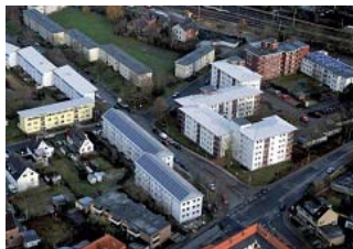
Die Sanierung der Wohnanlage kombiniert passiven Wärmeschutz mit aktiver Nutzung der Solarenergie.
